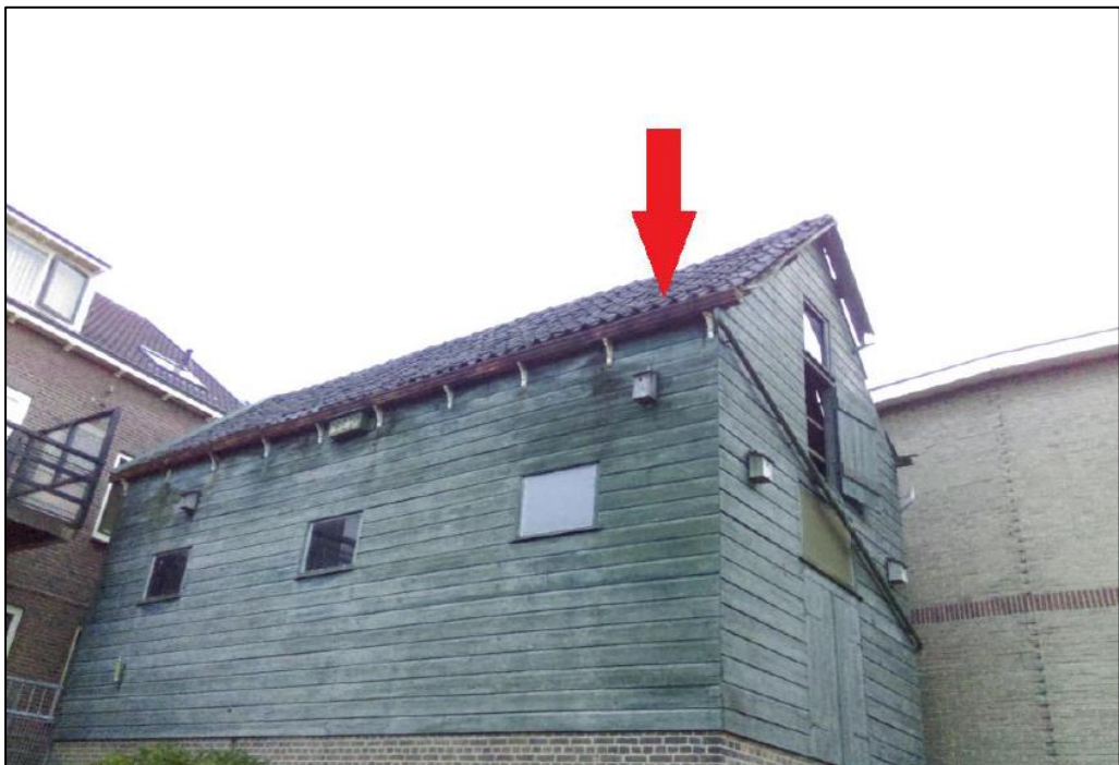
Locatie van de invliegopening van de gierzwaluwnestplaats op de Baas-locatie.
