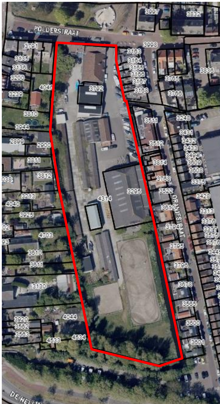
Figuur 2-2 Plangebied is aangegeven met rode kader (bron: Luchtfoto NL 20120 © CycloMedia Technologie B.V.)
