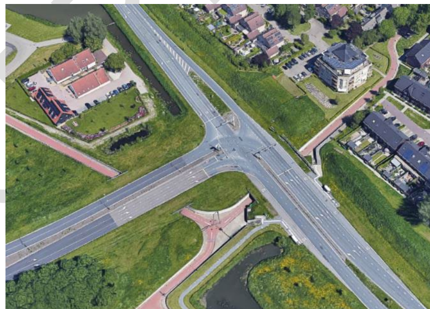
Figuur 18 Voorbeeld fietsonderdoorgang (Houten)
